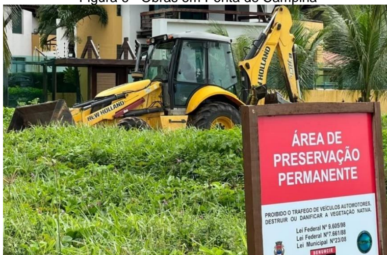
Figura 6 - Obras em Ponta de Campina
