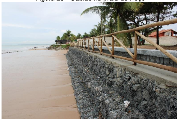
Figura 25 - Gabião na praia do Poço
